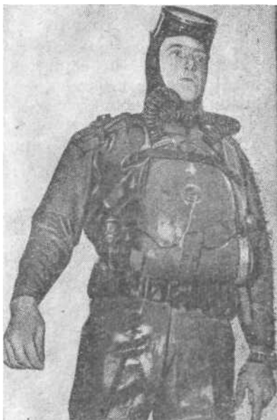
Военный пловец в закрытом каучуковом комбинезоне и снаряжении. Балластный пояс и дыхательный аппарат типа «Оксижерс» (закрытый)
