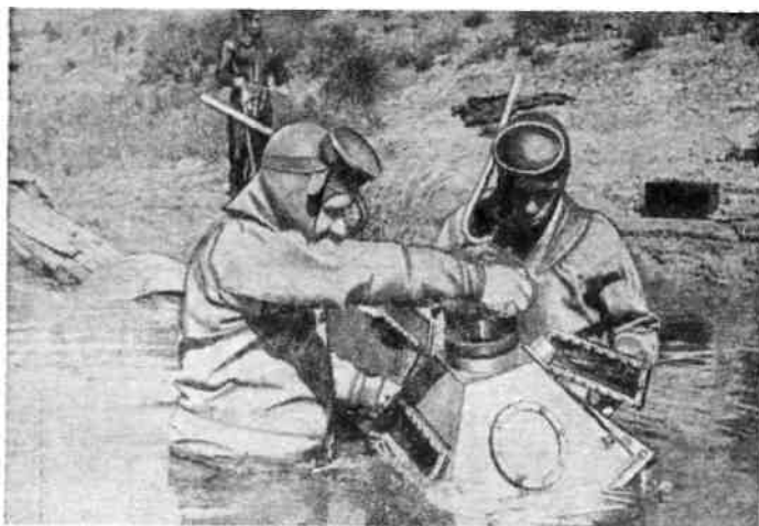
Рис. 2. Подготовка фотообокса к съемке газопровода
